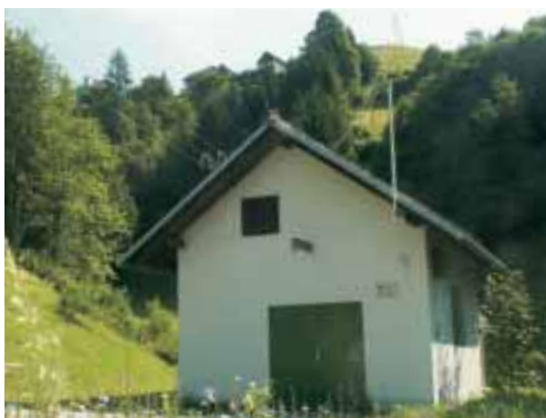
Elektrarna podjetja Elektra Kranj
